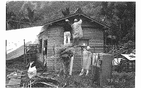
仮設住宅建設を支援(1999年12月)
